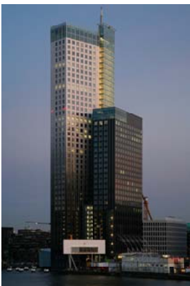
Maastoren (Rotterdam, Niederlande)
